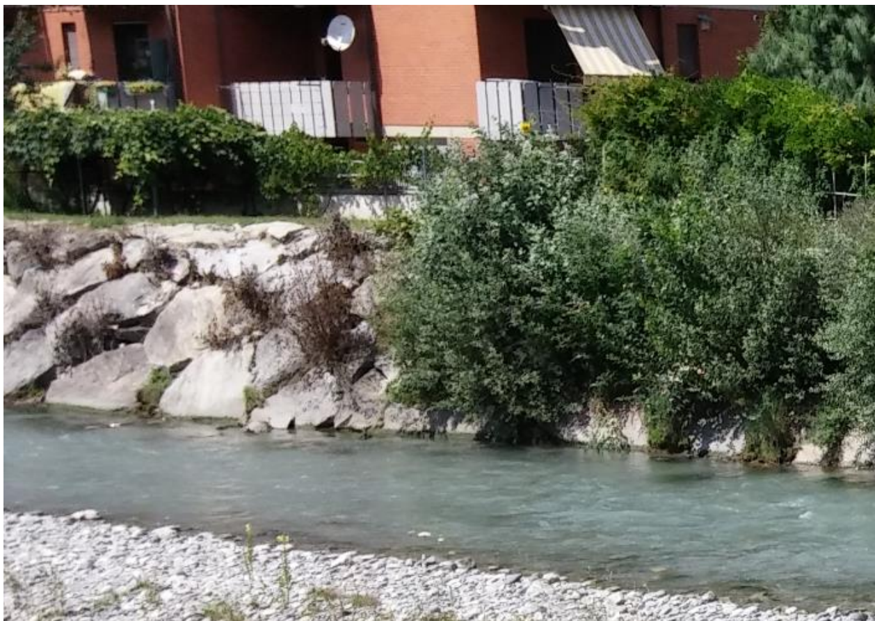
Fig. 6 – Foto della sponda sinistra della Dora Riparia, a monte del Ponte in Ferro, costituito da massi intasati
